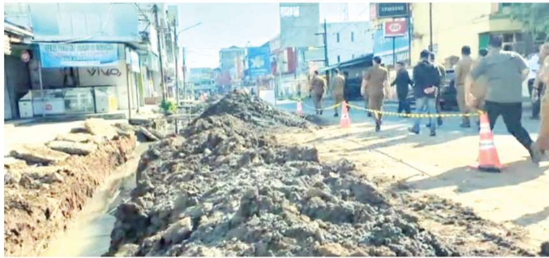
BETONISASI. Kondisi pekerjaan betonisasi yang digelar Dinas Pekerjaan Umum dan Penataan Ruang Kota Serang di salah satu ruas jalan, Senin (13/4). Pada tahun ini, Pemerintah Kota Serang menargetkan betonisasi 17 ruas jalan.
